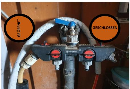
Aufmachen kann man den Wasserhahn rechts von den blauen Spinden. Hier müsst ihr erst den Schalter aufdrehen, der zum langen Wasserschlauch führt (hier im Bild der ganz links) und dann den blauen Hahn öffnen. Überprüft bitte immer, ob ihr
